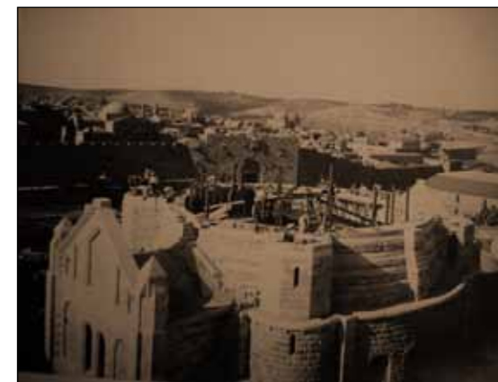
Bilder vom Bau der Dormitio.
